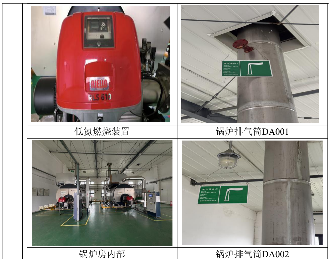
图 2-3 项目锅炉现状照片
