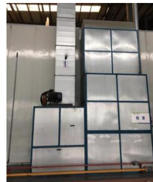
修补喷漆室处理设置
